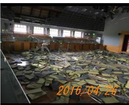
剥離した天井板
