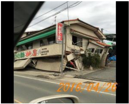
益城町の倒壊現場風景
