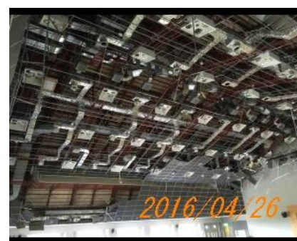
天井板が剥離して落下
