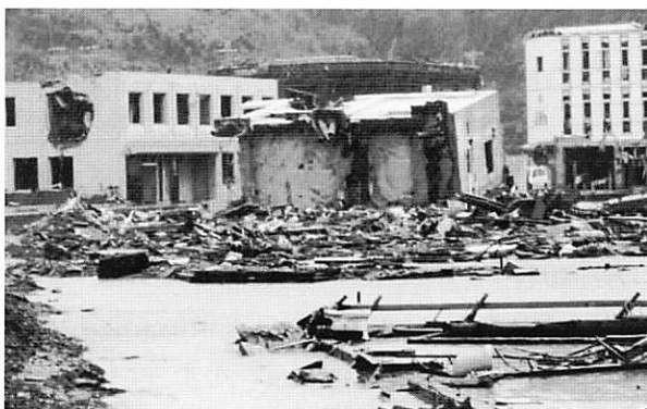
大震災発生直後の女川港 (基礎杭まで抜かれ横倒りになった警察署)
