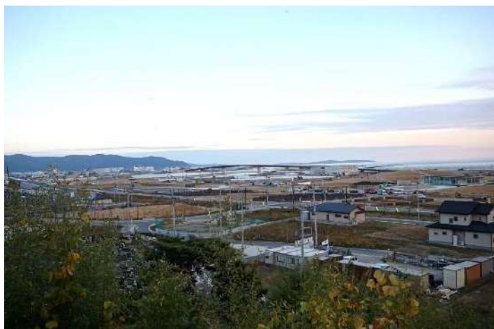
石巻で最も被害の大きかった、門脇、南浜地区の復興状況
